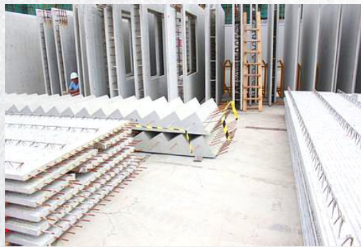
叠合板式混凝土剪力墙结构
