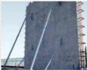
现场斜支撑安装
